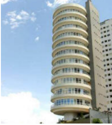
.Şekil 3.18. Suite Vollard isimli bu apartmanın her dairesi, kendi özel mekanizmaları ile diğerlerinden bağımsız olarak dönebiliyor. [ 15 ]
